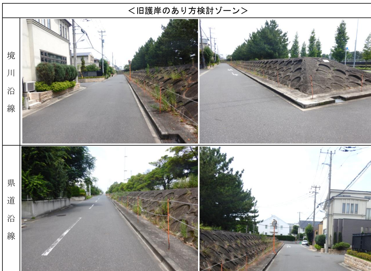
図 11. 入船三丁目地区の旧護岸あり方検討ゾーン現況写真
