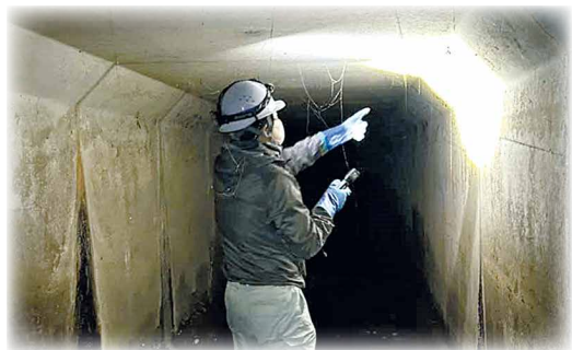
職員による1月30日の点検時の様子
