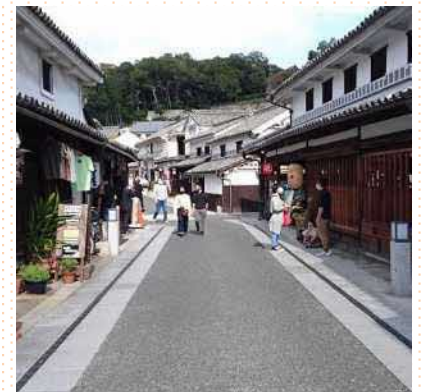
スリット型側溝の整備例
