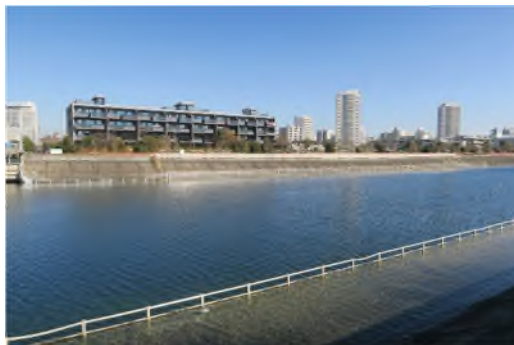
図9 新町地域の護岸（小段）水没箇所
